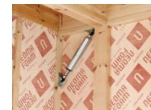
2階建ての場合、1階の柱の部分に設置。
